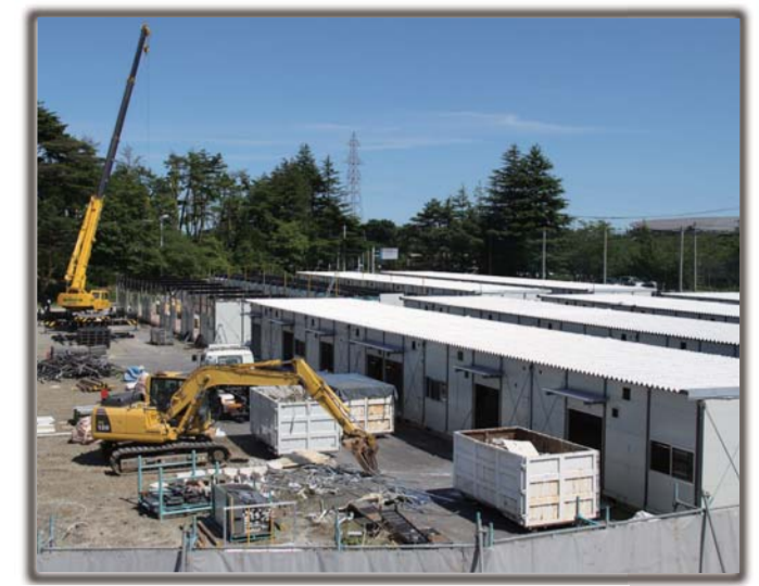
解体工事（七ヶ浜中学校第2グラウンド）
