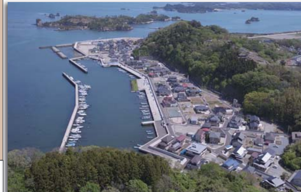
④ 土地区画整理事業 (代ヶ崎浜 B 地区)
