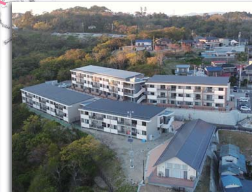
③ 災害公営住宅 (花洲浜地区)
