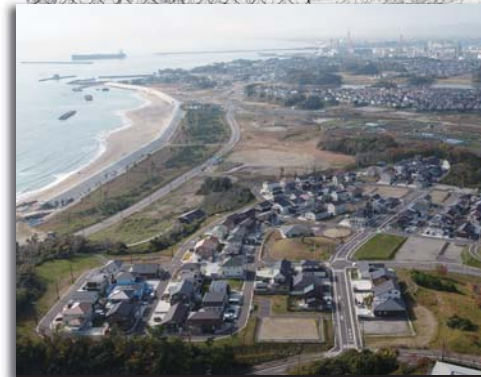
③ 防災集団移転促進事業 (笹山地区)
