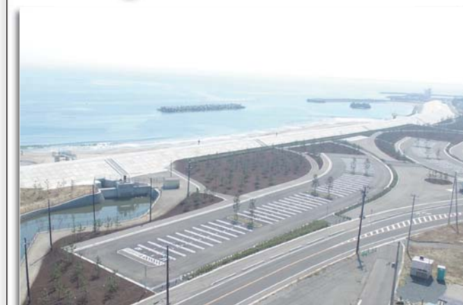
② 菖蒲田浜海浜公園南側 (H30.3 完成)
