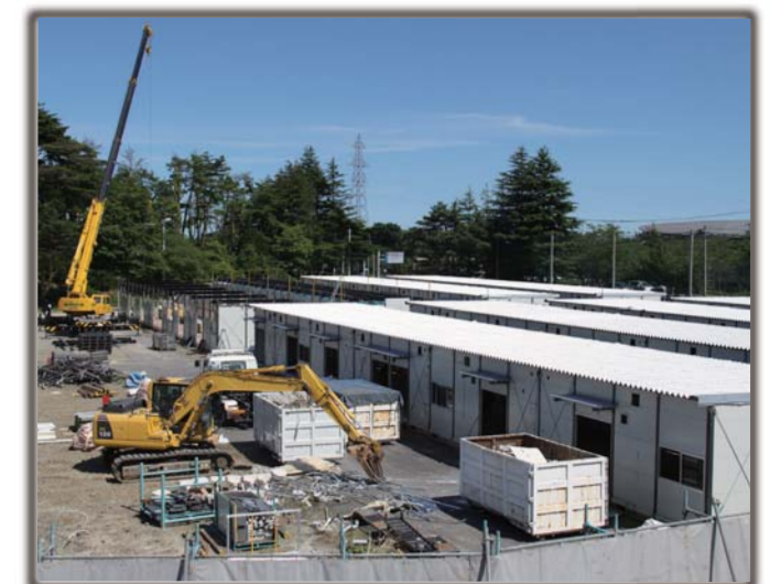
解体工事（七ヶ浜中学校第2グラウンド）
