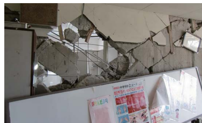
全壊した七ヶ浜中学校
