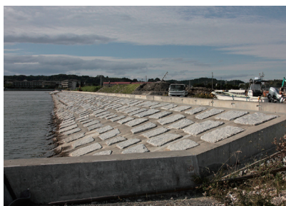
磯崎漁港の自然石護岸
