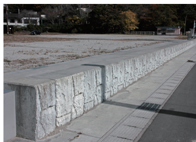
浜田漁港堤防の表面処理
