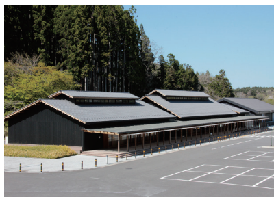
松島町石田沢防災センター
