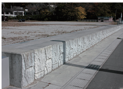
浜田漁港堤防の表面処理
