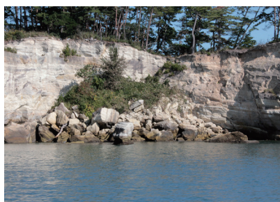
海食崖の崩落
