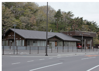
東松島消防署鳴瀬出張所
