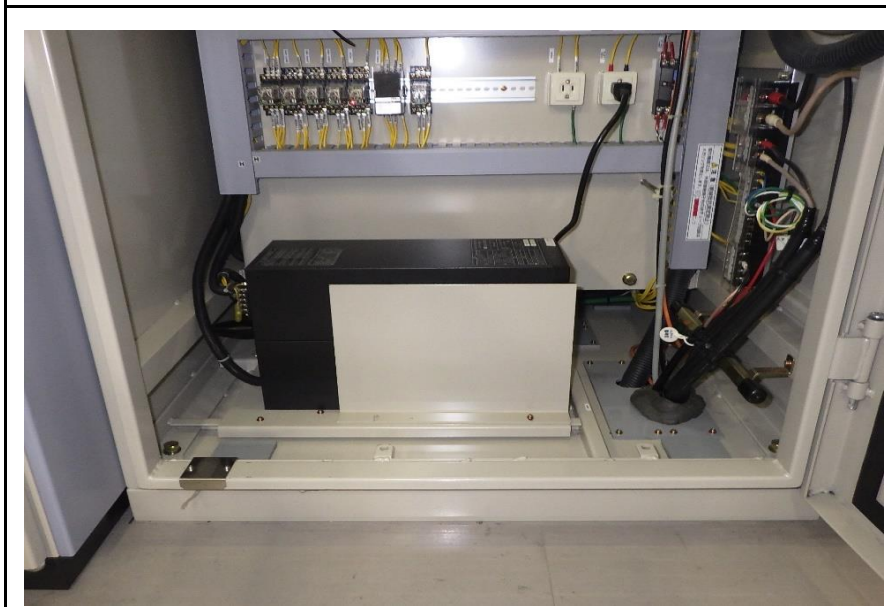
上下水道事業所 (中央監視室) テレメータ盤内 UPSバッテリー交換用 近影
