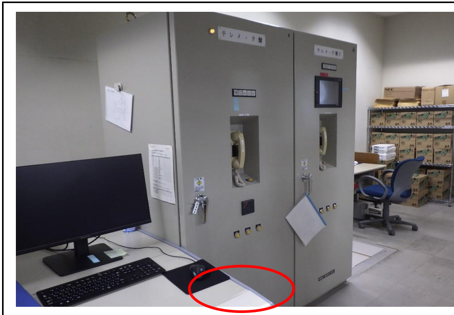
上下水道事業所 (中央監視室) テレメータ盤内 UPSバッテリー交換用
