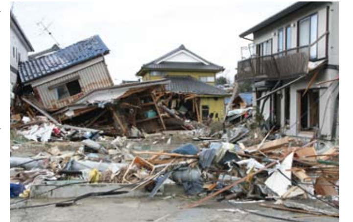
館下の被災家屋(平成23年3月17日撮影)
