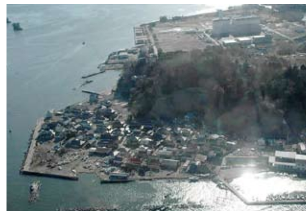
震災後の代ヶ崎浜西地区。地盤沈下により満潮時に冠水するところもあった。（平成23年3月27日撮影）
