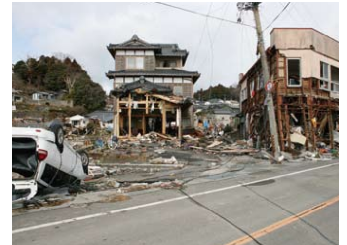
車はひっくり返り、道路や家屋の1階はガレキで埋め尽くされた。(平成23年3月17日撮影)
