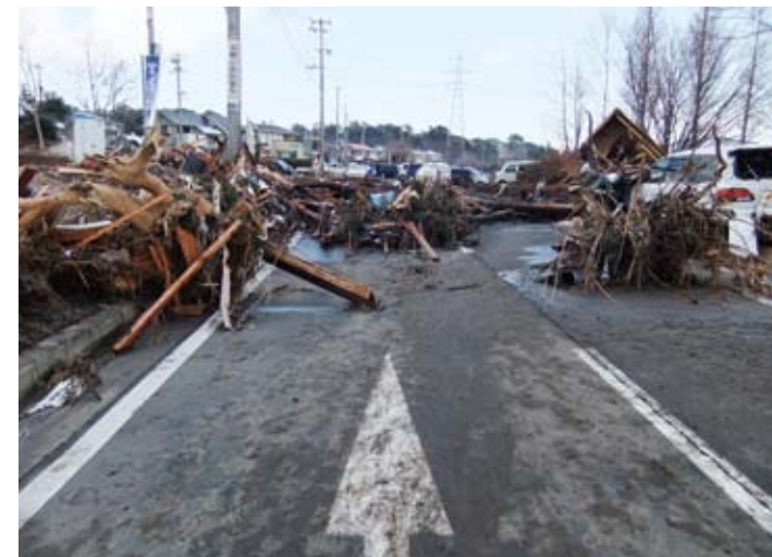
津波で流されたガレキが汐見橋付近の町道を埋めつくしたが、自衛隊の復旧活動により3月13日には車が通行できるようになった。(平成23年3月12日撮影)
