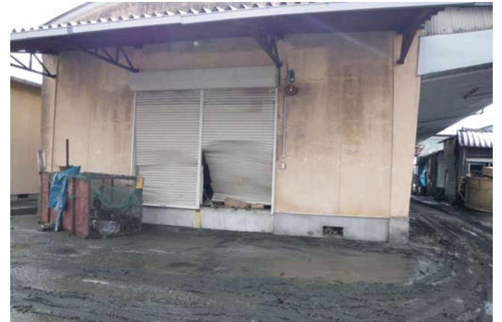
地区内の道路は汚泥で覆われ、住民はその片付けに追われた。(平成23年3月17日撮影)
