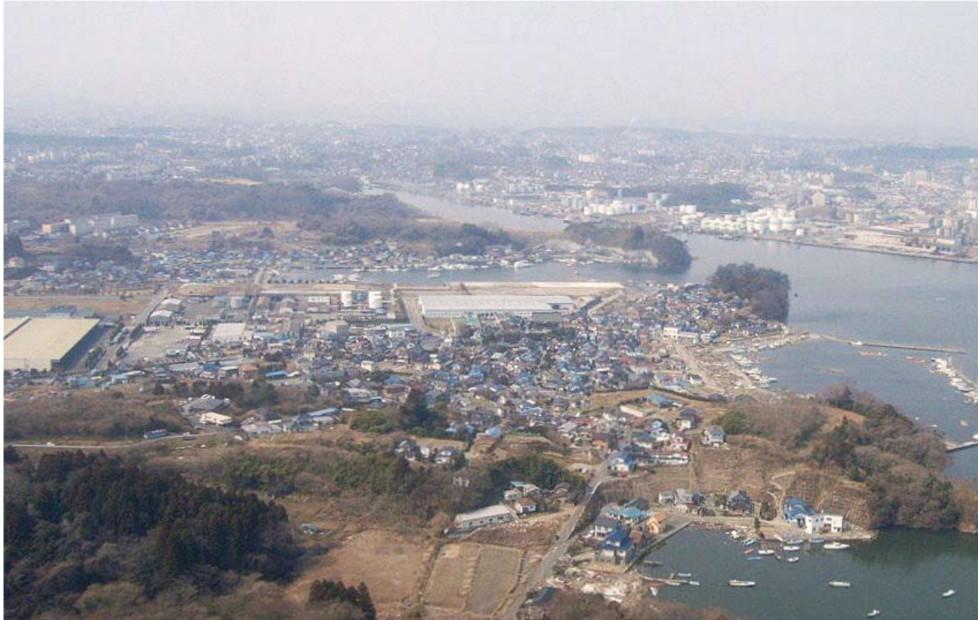
被災後の東宮浜地区の様子。23軒が床上・床下浸水の被害を受けた。(平成23年3月30日撮影)
