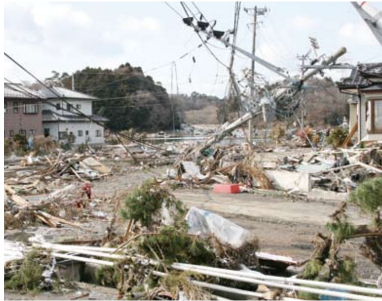
代ヶ崎浜では電気の復旧が遅れた。送電線や電信柱の被害が大きかったことがその理由の一つであった。(平成23年3月17日撮影)
