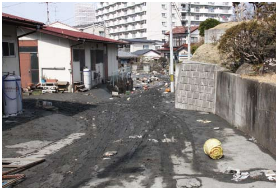
貞山堀に接する区域では、多くの家屋が津波の浸水を受けた。(平成23年3月13日撮影)
