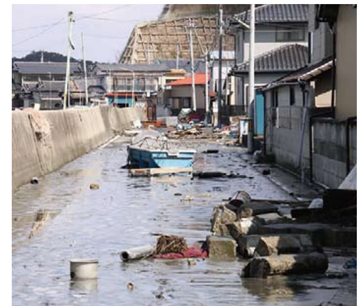
震災翌日の代ヶ崎浜清水地区。汚泥やガレキが道をふさいだ。（平成23年3月12日撮影）
