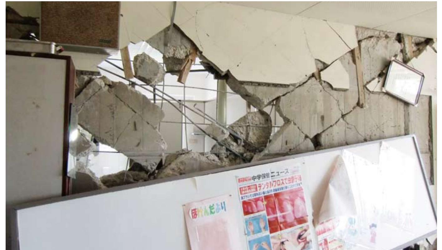
地区内の七ヶ浜中学校では、建物が大きく破損した。(平成23年4月2日撮影)
