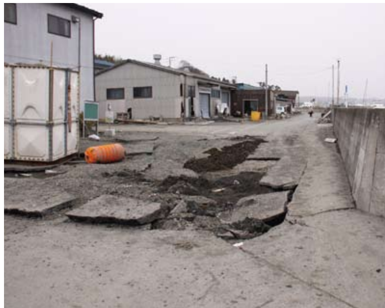
地盤沈下により崩れた道路(平成23年3月20日撮影)
