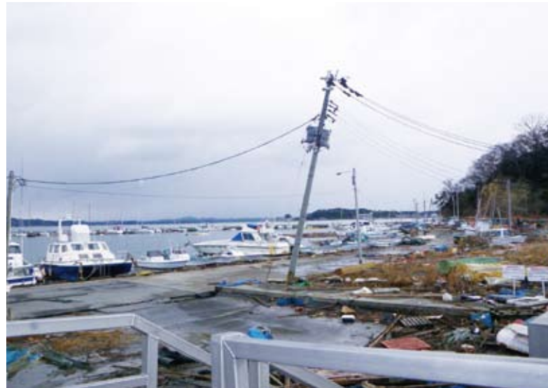
東宮浜港では、地盤がかなり沈下した。(平成23年3月17日撮影)
