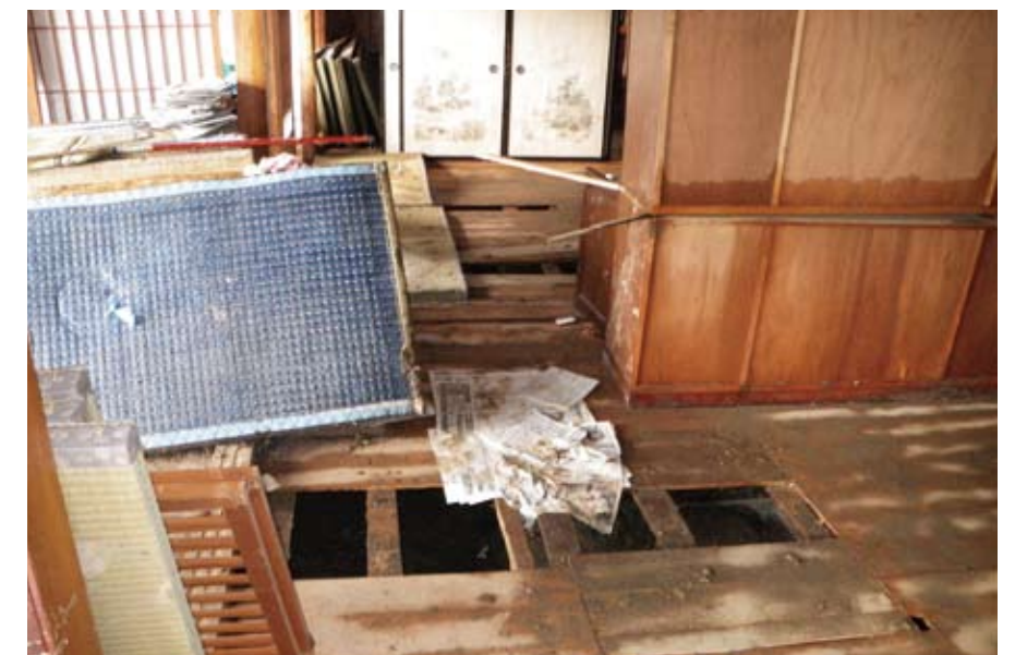
被災した家屋内。隣近所助け合いながら復旧に当たった。(平成23年3月17日撮影)
