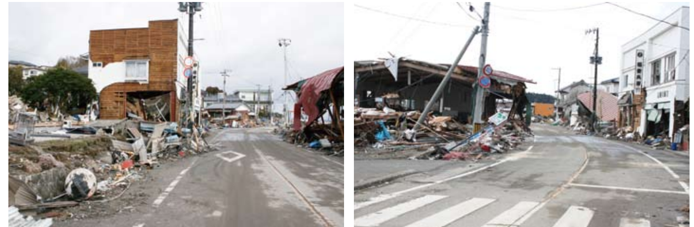
(下) 約1週間後には路上のガレキが撤去された。（平成23年3月17日撮影）
