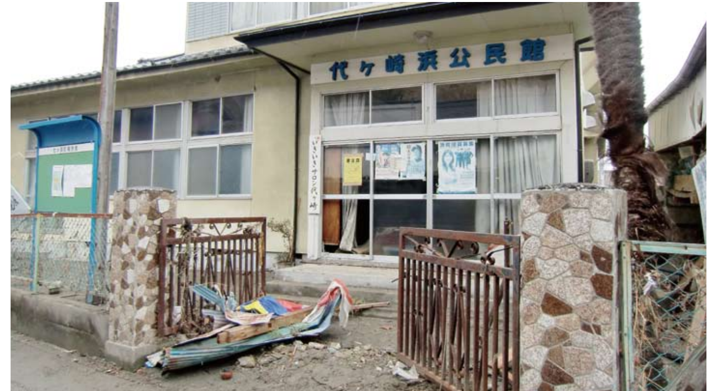
大きな被害を受けた公民分館。避難所として使えなかったことは、区民にとって大きな痛手となった。(平成23年3月26日撮影)
