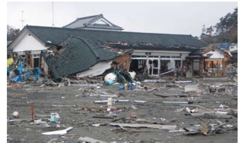
被災した花洲浜地区公民館(平成23年3月17日撮影)
