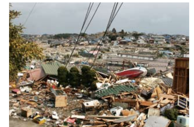
津波が浸水した地区には、多くのガレキが残された。(平成23年3月17日撮影)
