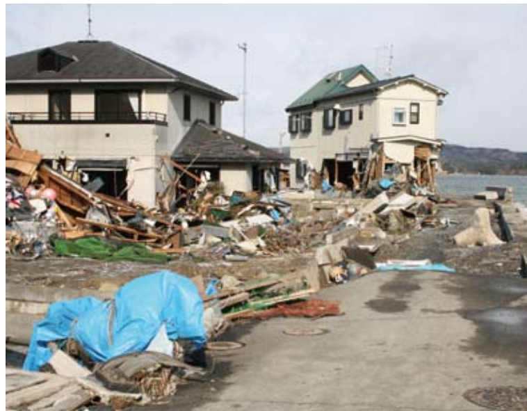
家も堤防も破壊された代ヶ崎西地区(平成23年3月17日撮影)
