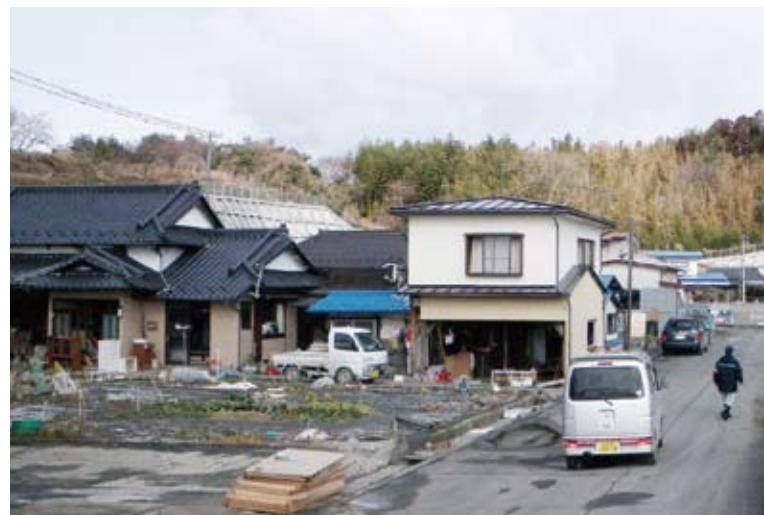
多くの家屋が床上・床下浸水の被害を受けた。(平成23年3月17日撮影)
