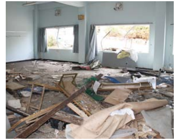
被災後の公民分館。1階の天井付近まで津波が浸水した。(平成23年4月2日撮影)
