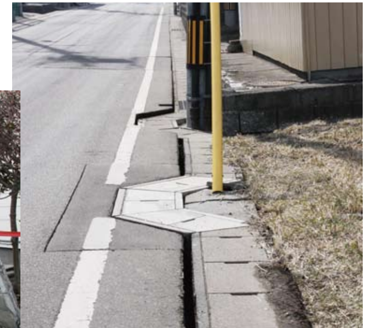
津波の被害がなかった区域でも、地割れや地盤沈下、ブロック塀の倒壊など、大きな被害を受けた。(平成23年3月13日撮影)
