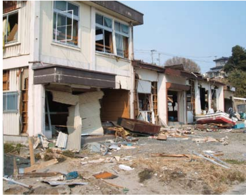
松ヶ浜漁港の向かいにあった宮城県漁業協同組合七ヶ浜支所松ヶ浜湊浜出張所も津波により被災した。 (平成23年3月30日撮影)
