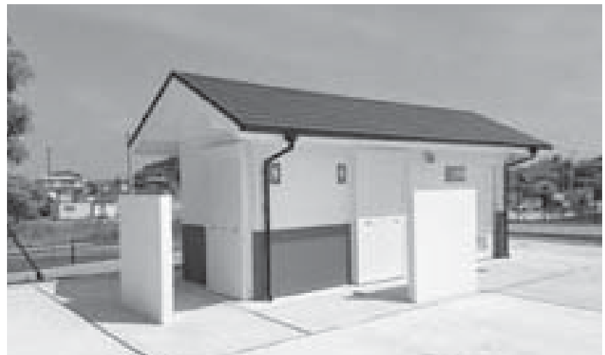
▲防災広場に設置されたトイレ
