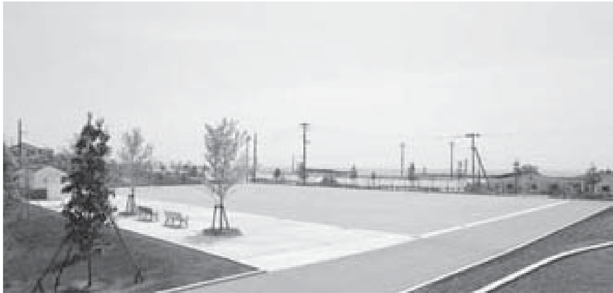
▲憩いの場、レクリエーションなどに使用できる防災広場
