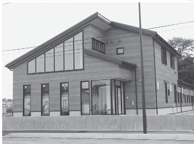
花渚浜館下地区に完成した水産共同利用施設（海苔加工施設）
