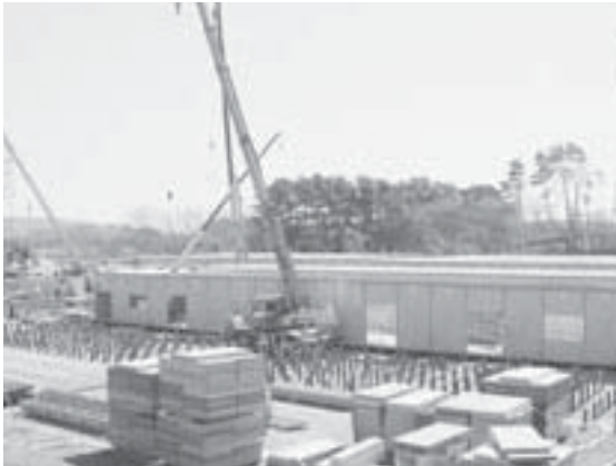
応急仮設住宅の建設風景
