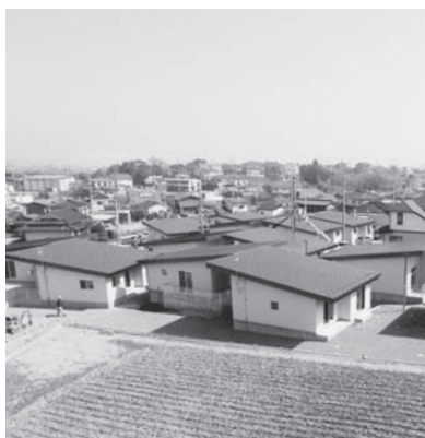
▲松ヶ浜西原地区に完成した災害公営住宅
