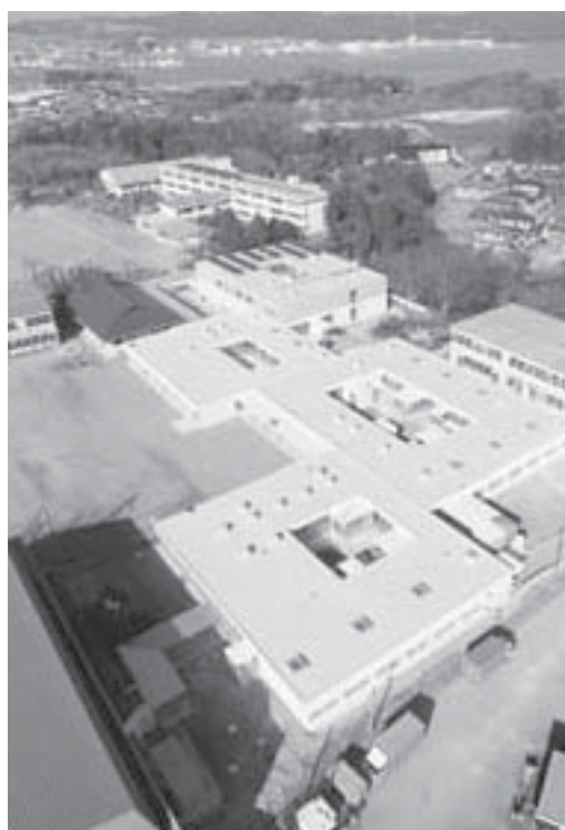
用途ごとに4つの棟に区分けされ、その一つ一つの中央に中庭を設置し太陽光を多く取り入れられるよう工夫が凝らされた新しい七ヶ浜中学校の校舎。この快適な空間で生徒たちの新たな学校生活が始まっています。
