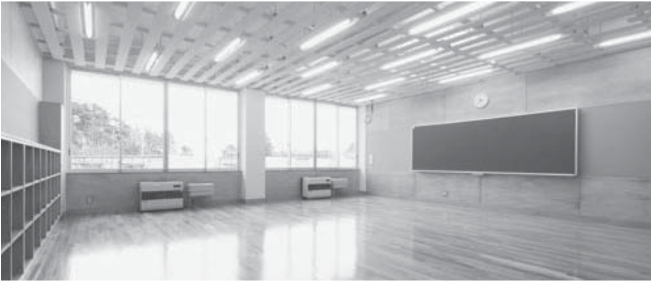
▲普通教室 木材を多く利用し、温もりのある雰囲気となっています。自然光を取り込みやすくするために大きな窓を設け、また天窗より取り込んだ光を格子状の天井によって拡散させ、明るく開かれた空間づくりをしています。
