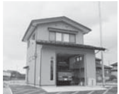
▲津波で被災し、新築した第3分団（花浜地区）の消防ポンプ車置場
