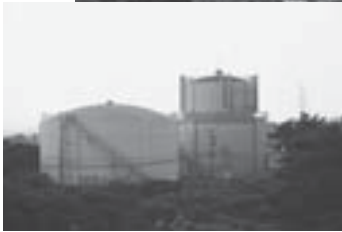
▲君ヶ岡配水池
