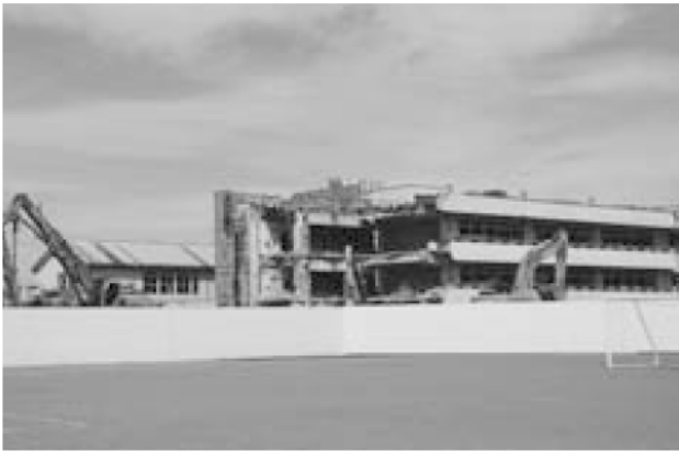
▲解体工事が進められている旧校舎
