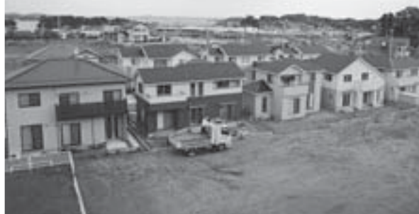
続々と住宅が立ち並ぶ御林地区
