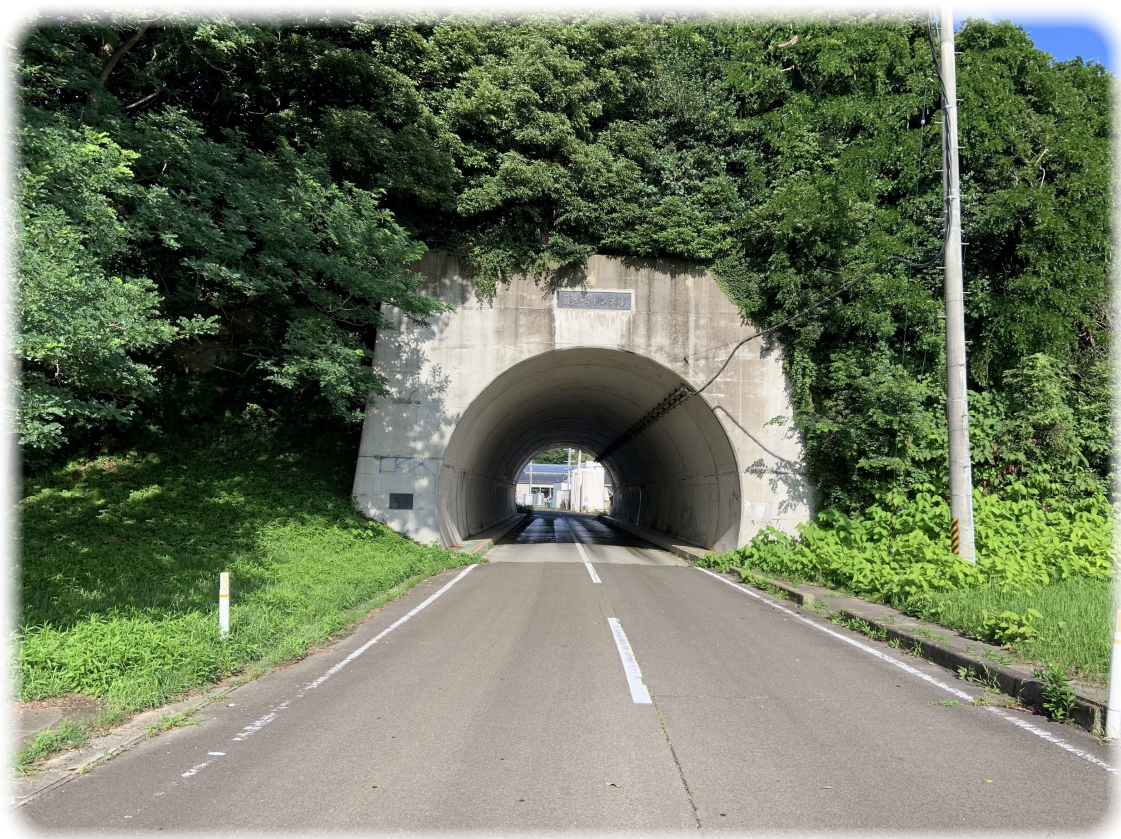
飛ヶ崎トンネル（七ヶ浜町松ヶ浜字洞坂）
