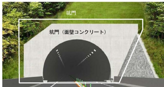
図 3.3 点検対象箇所（トンネル抗口部）
