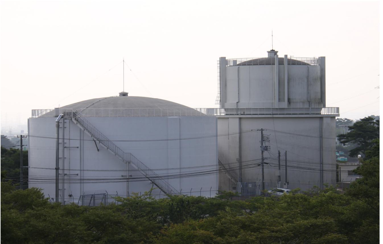
君ヶ岡配水池
