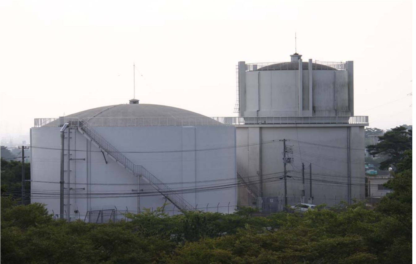
君ヶ岡配水池
