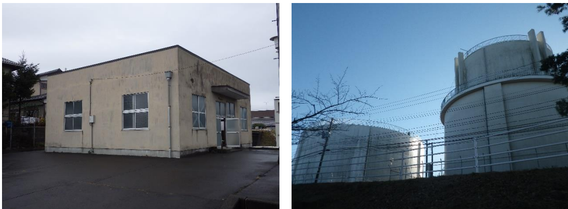
図 2.2 水道施設（左：遠山ポンプ場、右：君ヶ岡配水池）
