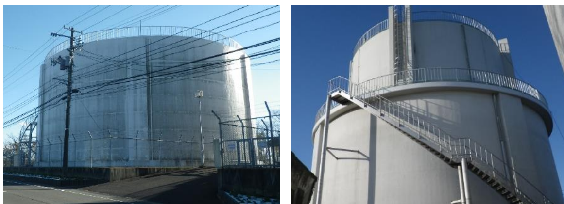
図 3.5 君ヶ岡配水池（左：No.1 タンク、右：No.2 タンク）
