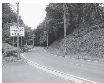
樹木伐採協力で見通しが良くなった
