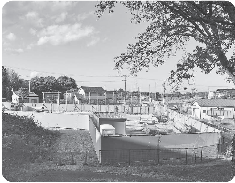
着々と進んでいる工事(令和6年4月から利用開始予定)
