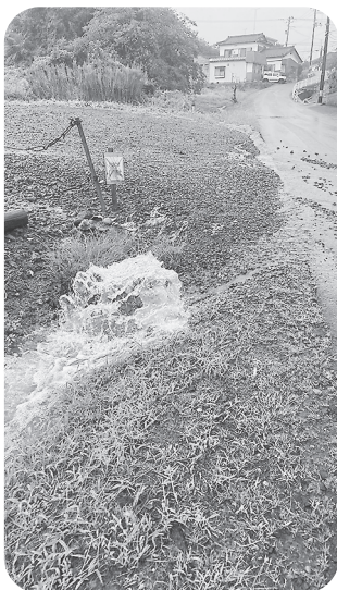
のりめん 法面を流れる雨水
