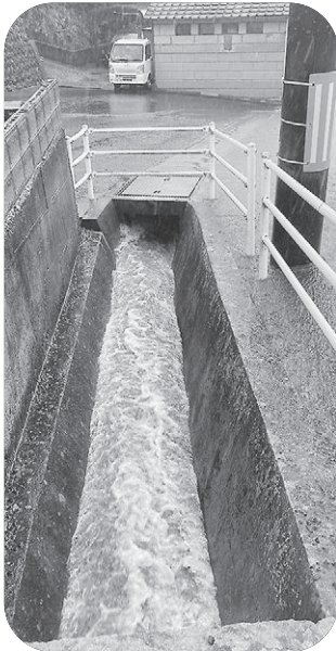
急勾配の側溝先のマンホール口
