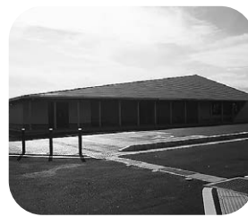
仕切りを設置
