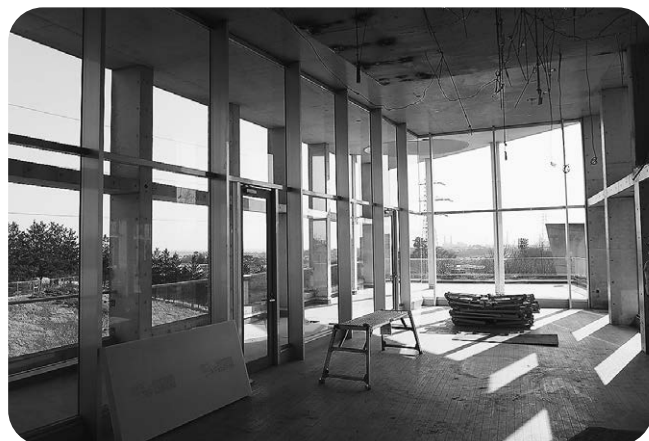
工事が進んでいるレストランエリア
