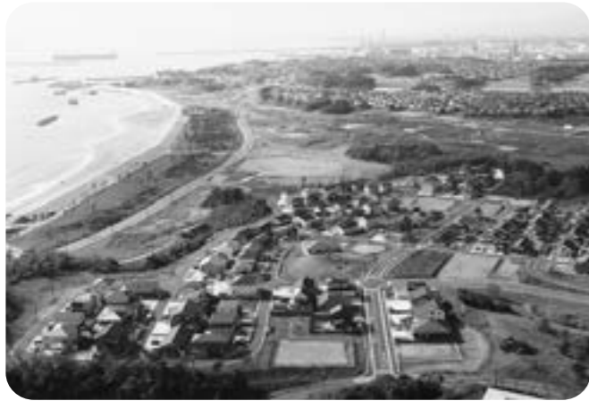
分譲が完了した笹山団地
