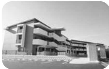
花洲浜地区災害公営住宅
