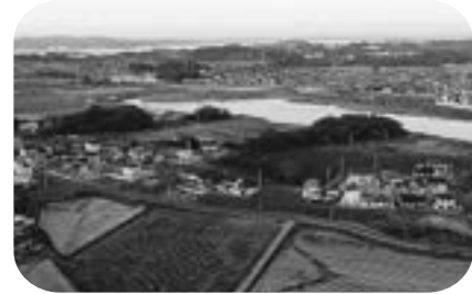
高台移転団地「菖蒲田浜中田地区」
