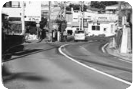
道幅が狭く危険なので歩道を設置してほしい
