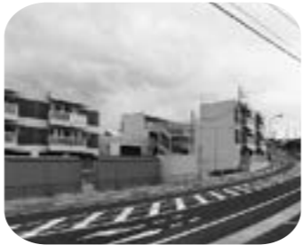
災害公営住宅(葛浦田浜)
