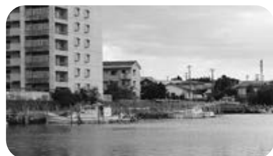
整備が待たれる貞山掘護岸（本町側）
