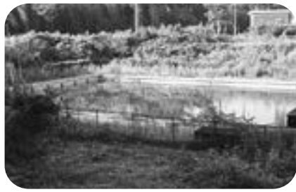
解体される亦小プール
