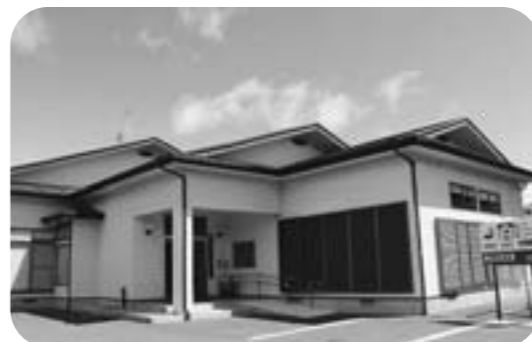
改修される境山公民分館
