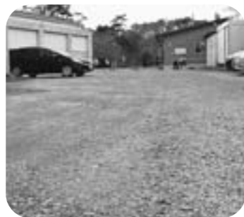
舗装を待つ通路
