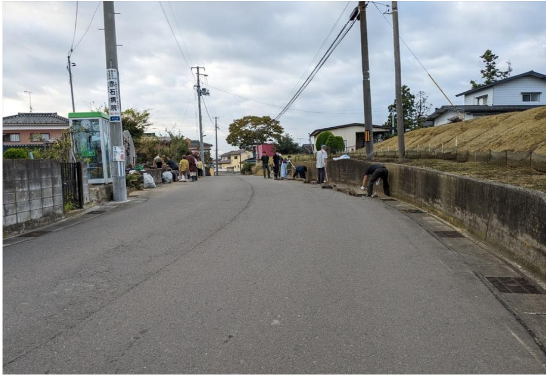
2023.9/10 道路掃除状況・側溝内部の土砂堆積がかなり多い。
