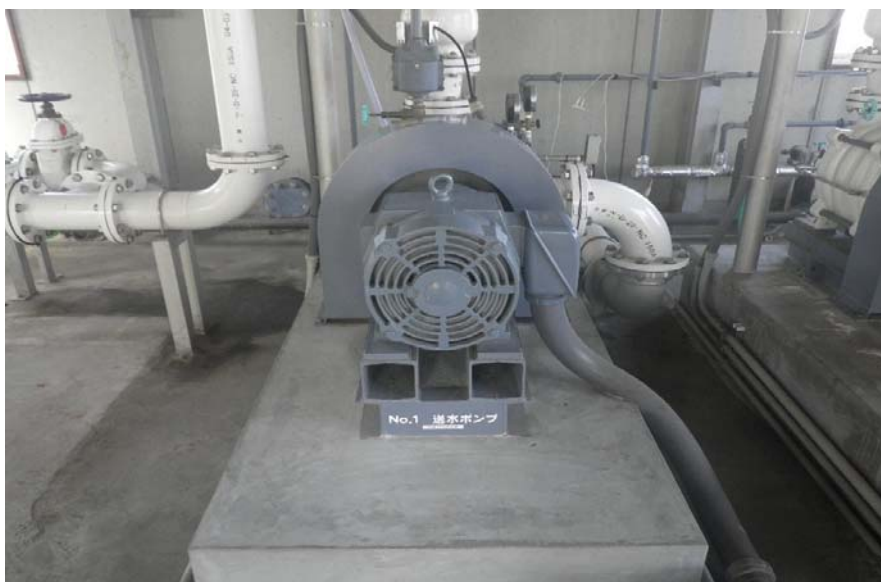
遠山ポンプ場 送水ポンプ分解整備 2 台 No.1送水ポンプ
