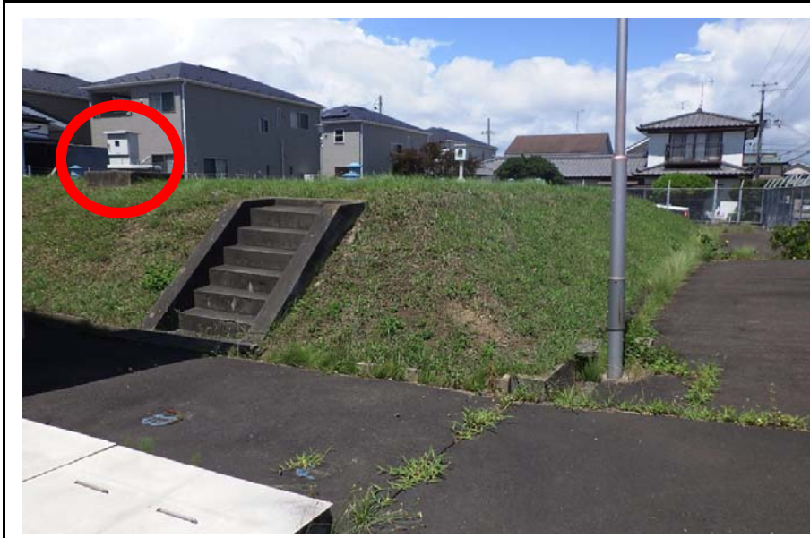
遠山ポンプ場 受水槽水位計交換 受水槽外観 全景
