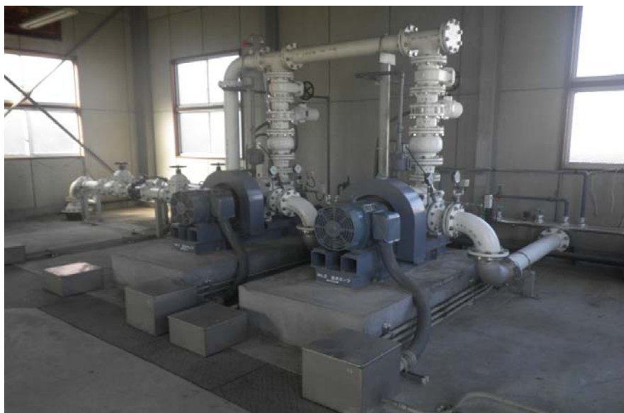
遠山ポンプ場 送水ポンプ分解整備 2 台 全景
