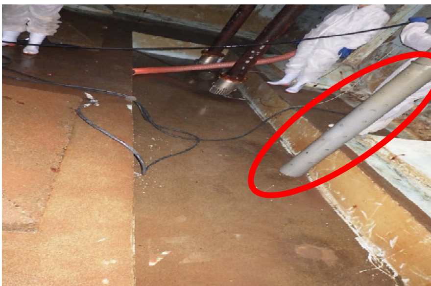
遠山ポンプ場 受水槽水位計交換 受水槽内部 防波管内 水位計 下部
