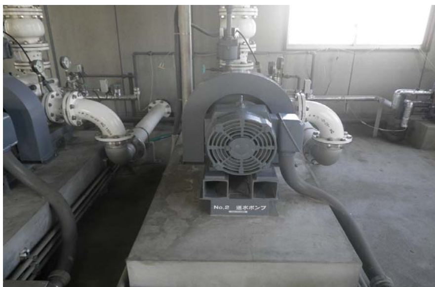
遠山ポンプ場 送水ポンプ分解整備 2 台 No.2送水ポンプ
