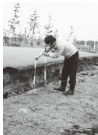
【宮城県沖地震】 町内道路の被害状況。また、町内各地で崖崩れやブロック塀の倒壊など、様々な被害が発生しました。
