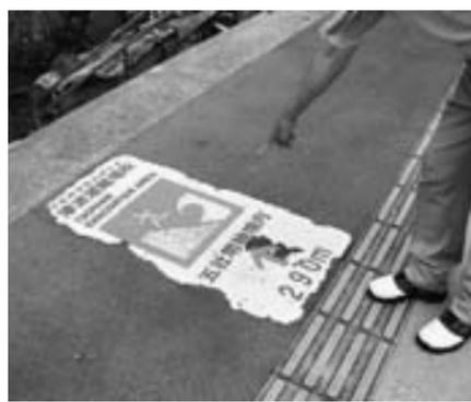
防波堤の路面標識の破損が目立つ（県の管理）
