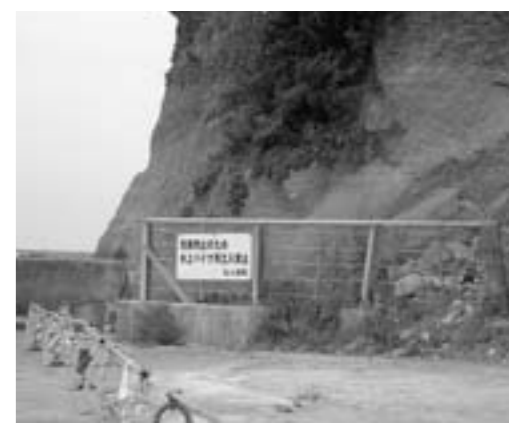
崩落して危険です
