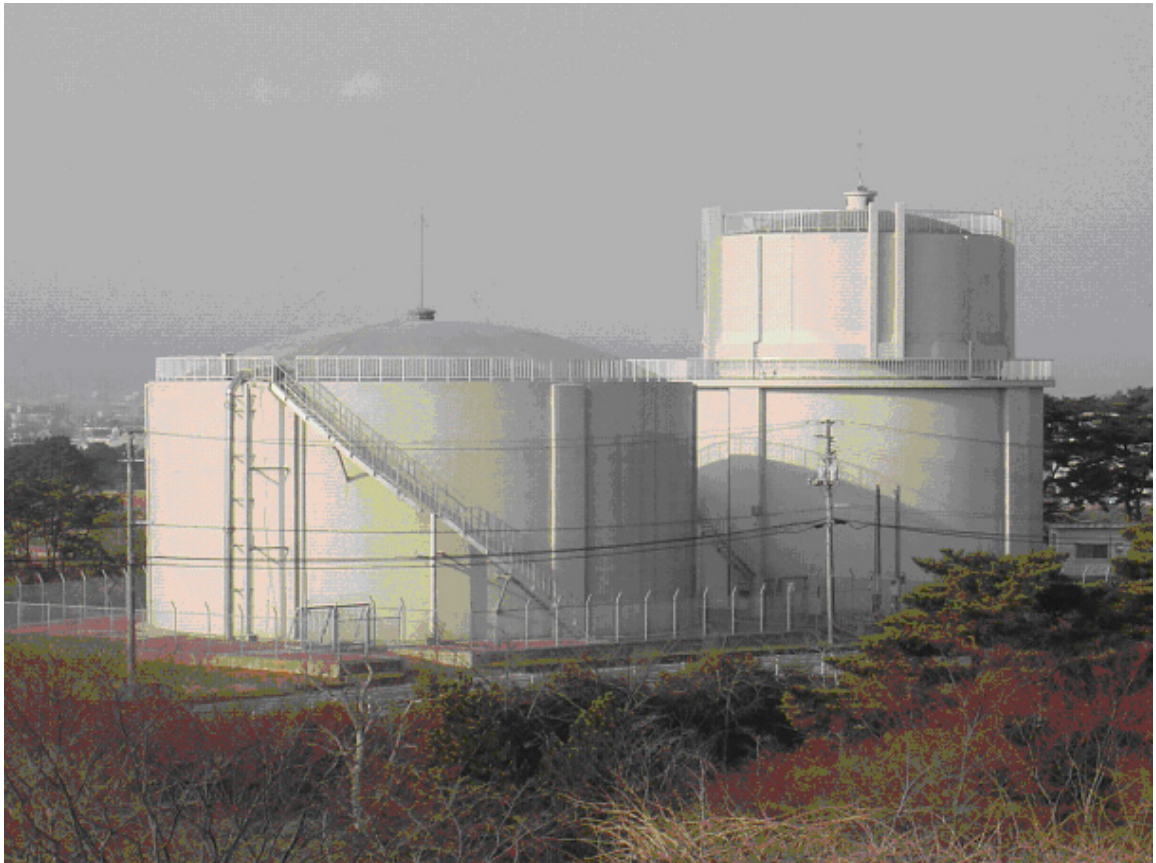
君ヶ岡配水池
