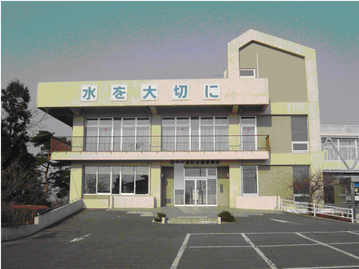
七ヶ浜町水道事業所
