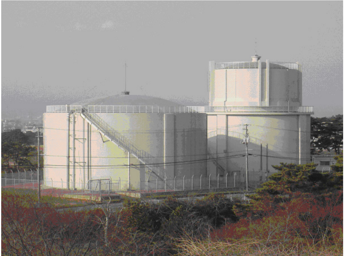
君ヶ岡配水池
